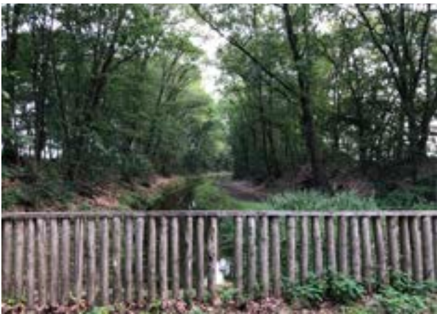
Zijaanzicht binnenzijde zuidwest
