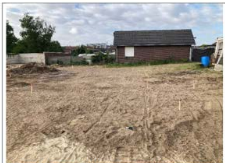
Foto 1: zuidelijk terrein voor aanvang sanering
