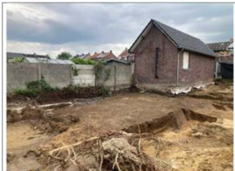
Foto 10: Eindsituatie na de graafwerzkaamheden zuidelijke spot
