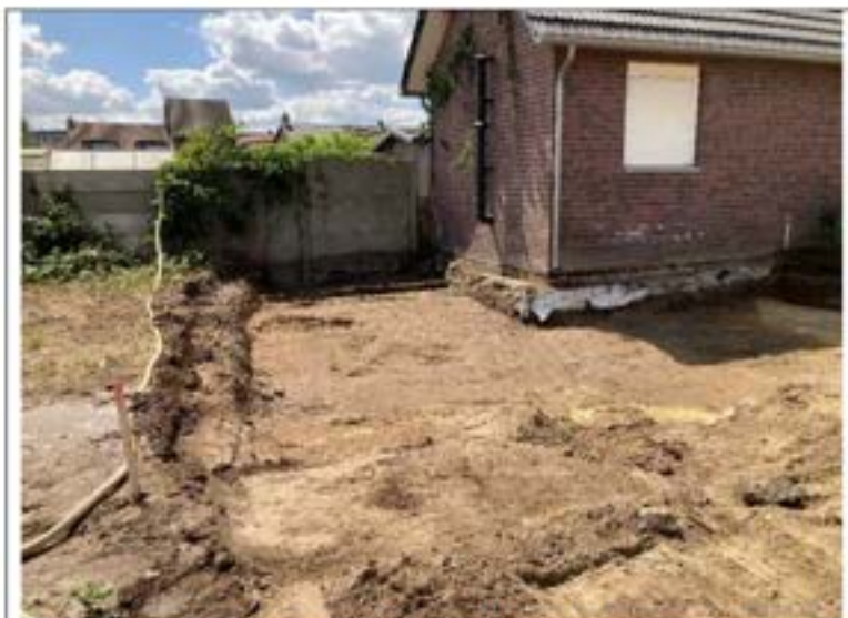
Foto 4: ontgraven asbesthoudende grond
