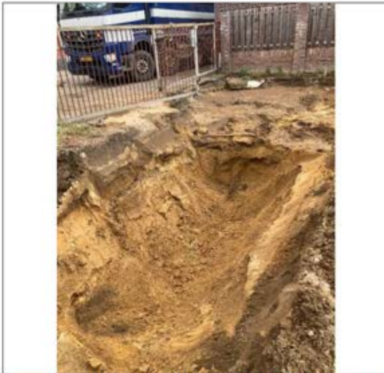
Foto 14: ontgravingsput ter plaatse van de ontgraven tank noordelijke spot
