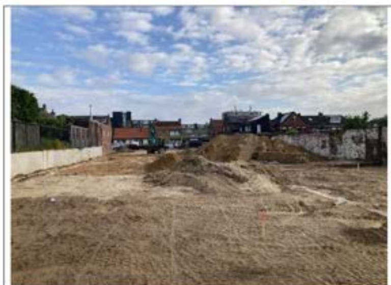
Foto 3: zuidelijk terrein voor aanvang sanering
