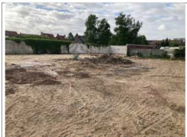
Foto 2: zuidelijk terrein voor aanvang sanering
