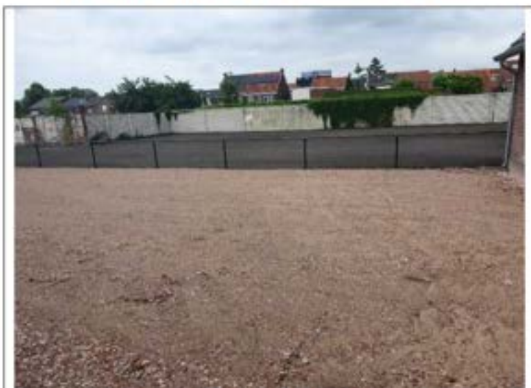
Foto 19: aanvulling van de zuidelijke spot met puin
