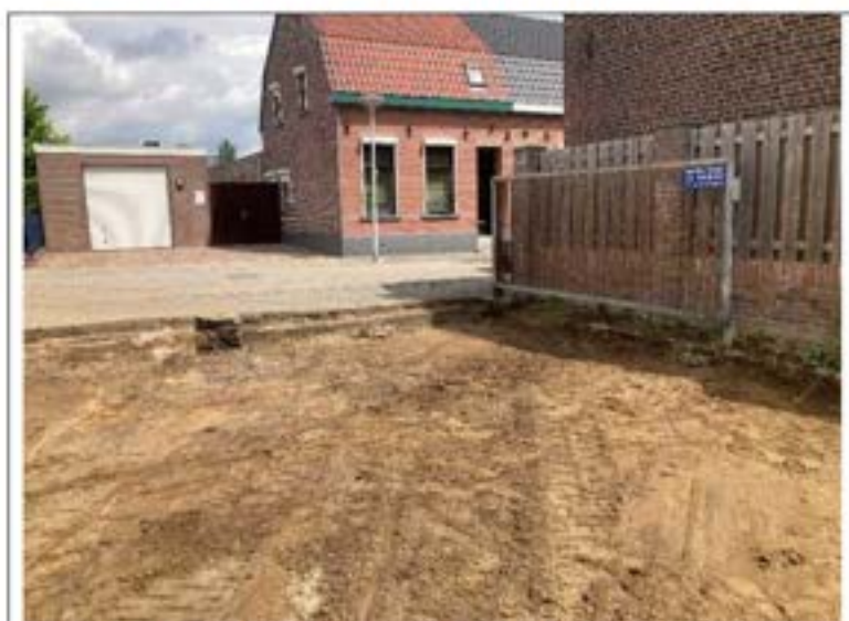
Foto 16: ontgraving van de grond noordelijke spot
