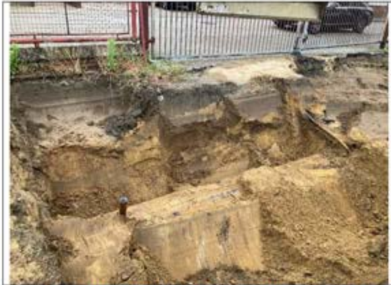
Foto 13: ontgraven van de ondergrondse tank noordelijke spot
